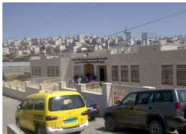
مبنى مركز أيار (2007 - 2008) الواجهة الرئيسية
