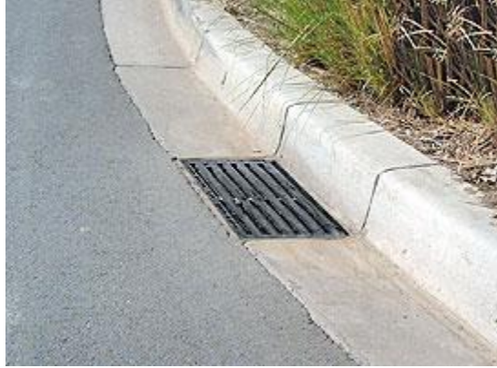
شكل (2-7) : gutter inlet
