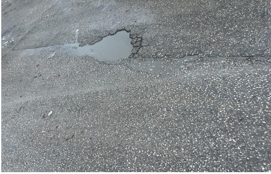
الشكل (3-4):- وجود الحفر بالطريق
