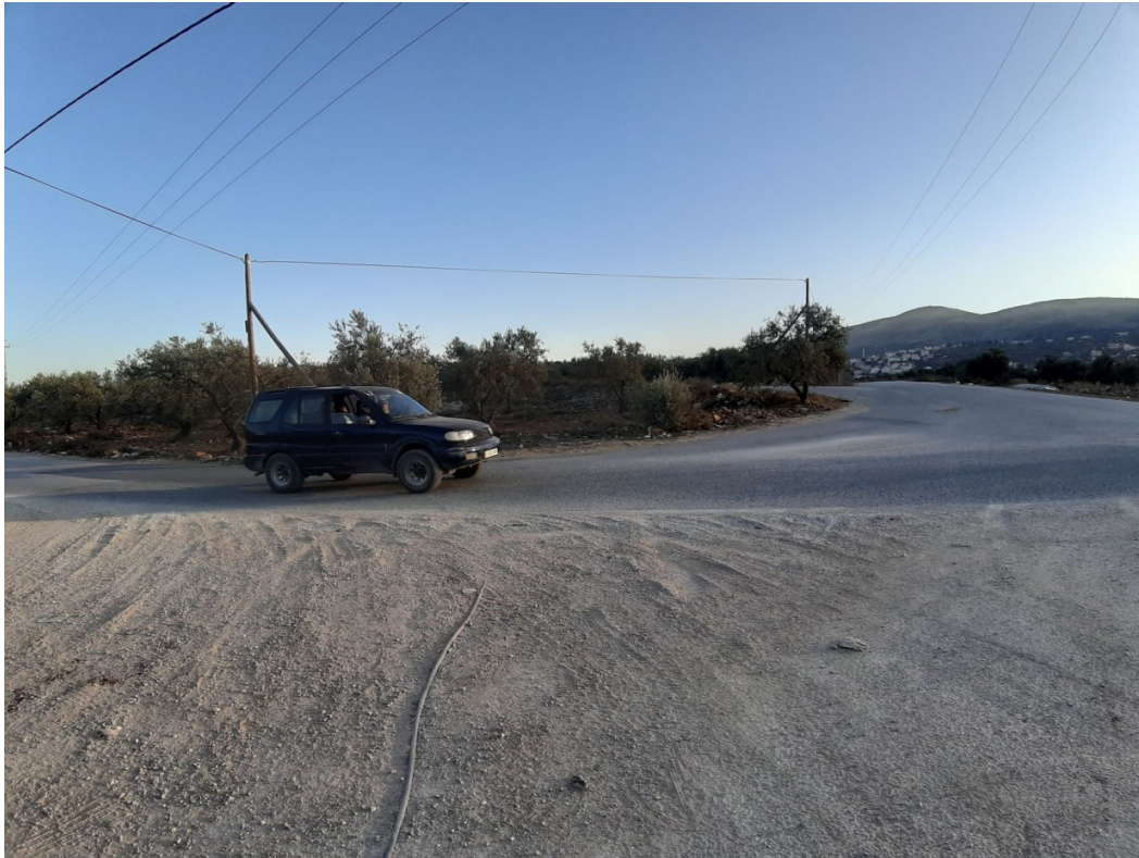
الشكل ( ٣-٥ ) يوضح اماكن تجمع التراب بعد جرفه من مياه الامطار في الطريق وسوء تصريف المياه .
