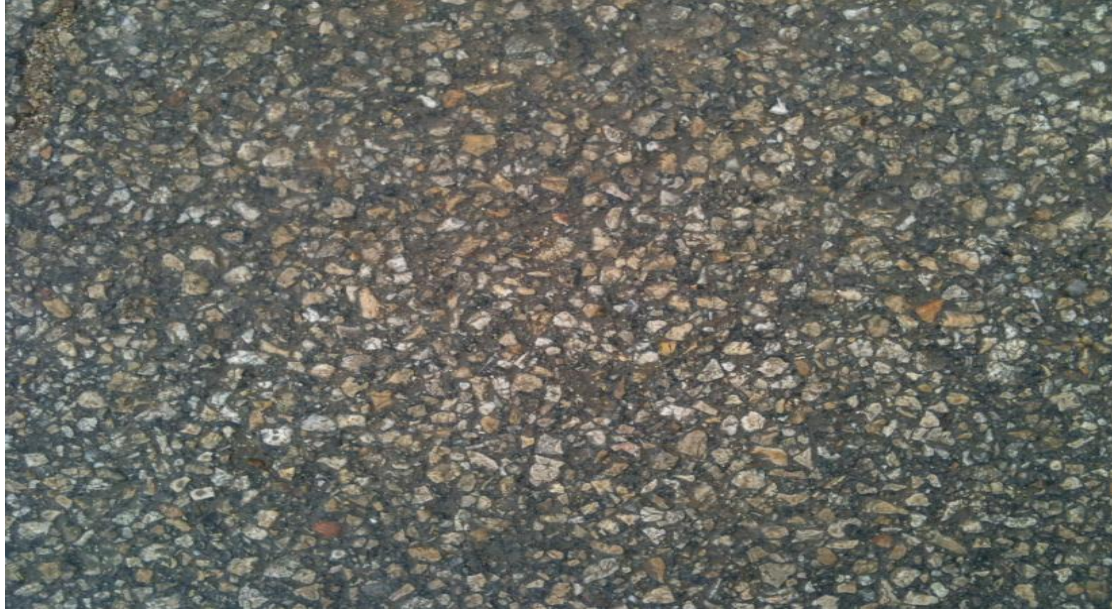
الشكل رقم (3-13) التطاير والتآكل
