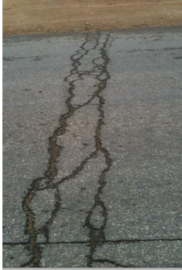
الشكل رقم (3-16) الشقوق الانعكاسية
