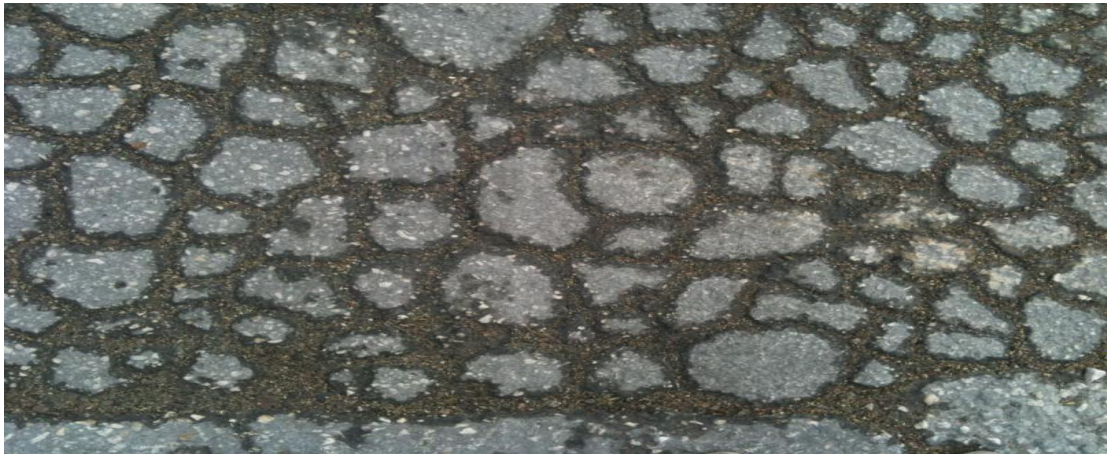
الشكل رقم (1-3) رسمة الشقوق التماسحية
