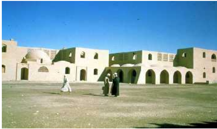
صورة (١-٢) المدخل الرئيسي للمدرسة
