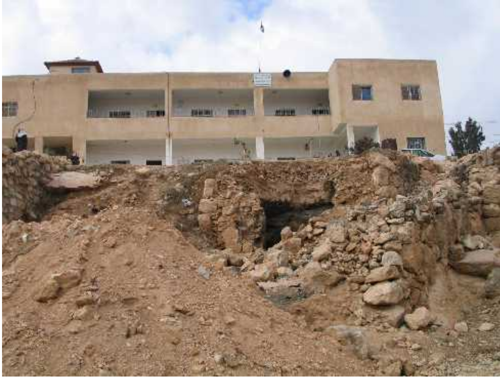
(أ - ) : انهيار التربة على جوانب ساحة مدرسة أبو العرقان الأساسية
