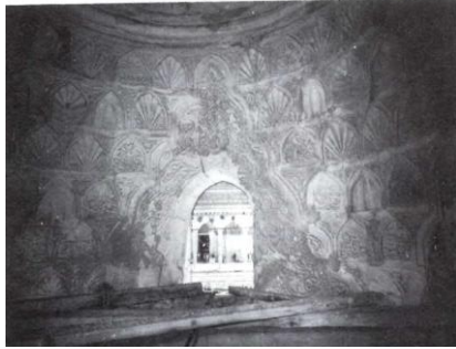
شكل رقم ( ٢٠, ٣٩ ) : قبة سبيل قيتباي تظهر منطقة الانتقال من الداخل- المصدر Mamluk Jerusalem
