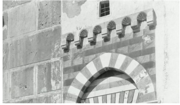
شكل رقم ( ٢٩،٢ ) : صورة تفصيلية توضح الزخارف ومواد البناء المستخدمة - المصدر د.عبد الحافظ أبو سرية
