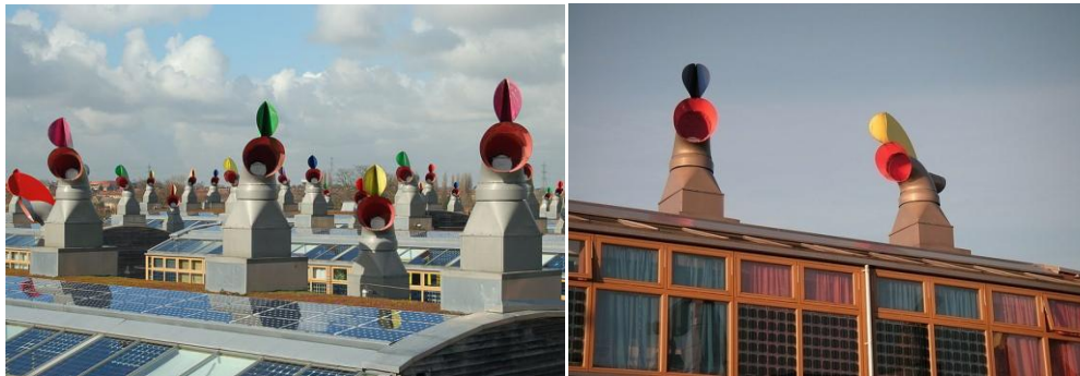
الشكل(25.5): نظام ملقف الرياح لاسترداد الحرارة ( https://en.wikipedia.org/wiki/BedZED ) (15/4/2017)
