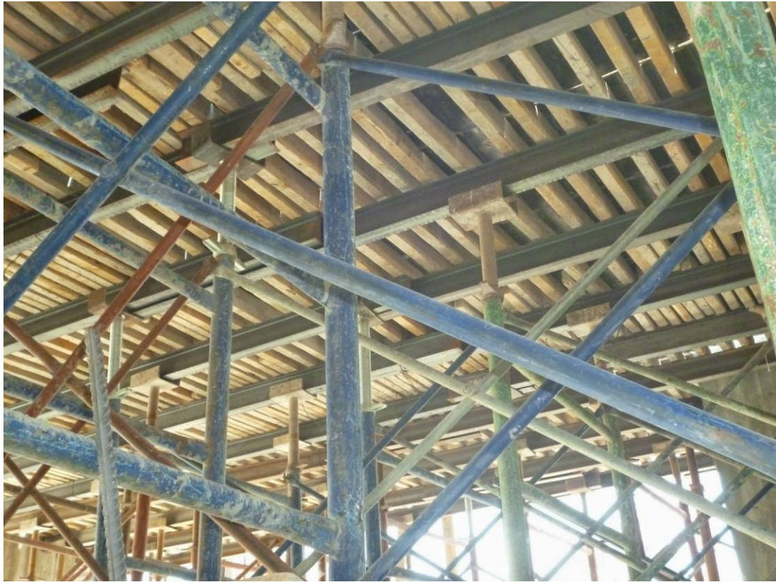
الشكل (2.4): نموذج الاسقف الخرسانية للمباني في فلسطين ( http://construction-and-architecture.blogspot.com ) (1/4/2017)
