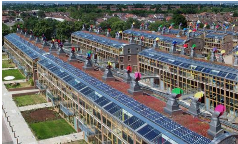
الشكل(20.5): الألواح الشمسية على اسطح مباني BEDZed (https://en.wikipedia.org/wiki/BedZED، 15/4/2017)
