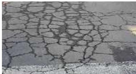
الشكل رقم (7-2) الشقوق التمساحية.
