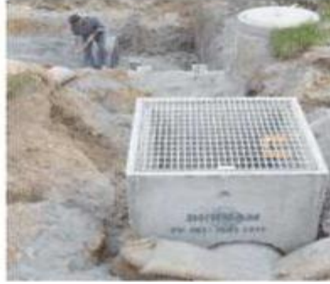
الشكل (7- 10) إقامة مجاري المياه تحت الأرصفة.
