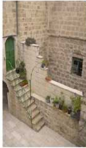
الدرج المؤدي الى المستوى الثاني في الجهة المقابلة للمدخل
