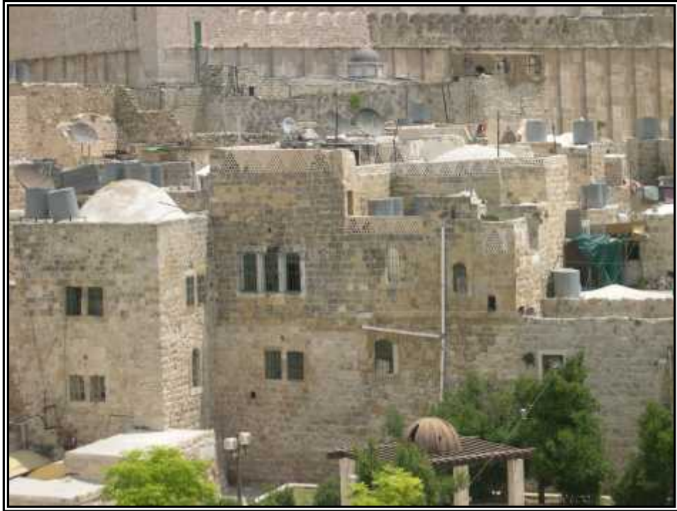
تبين هذه الصورة مجموعة من وجهات مباني في مدينة الخليل القديمة نلاحظ فيها بساطة المفردات المعمارية المختلفة وتكاملها لتشكل صورة جميلة تعكس الماضي والحاضر تصوير فريق العمل ( / / / / ) ( - )
