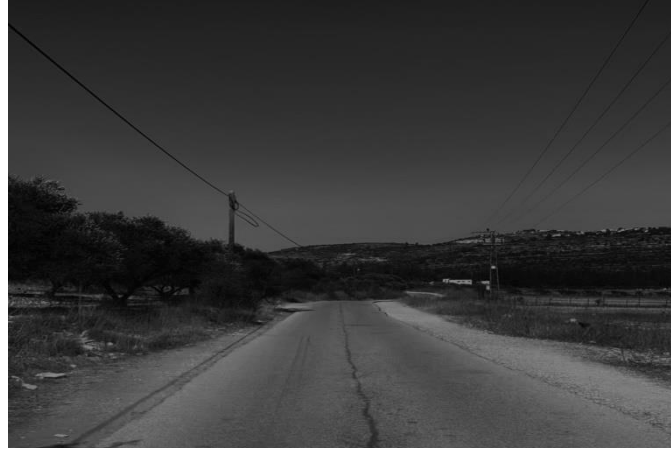
الشكل ( 7-3 ) يوضح عدم وجود مصابيح انارة في الطريق .
