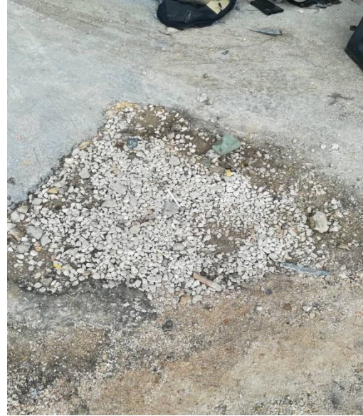
الشكل (3-5) : وجود الحفر بالطريق
