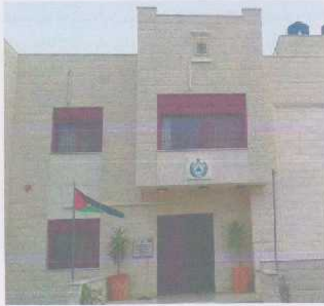
صورة (4-8) واجهة للمبنى. (المصدر: الباحث)
