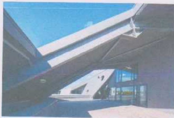
صورة (20-4) الفراغ الداخلي.
