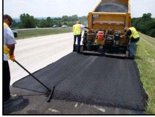
الصورة (2-8): طبقة الاسفلت اثناء التنفيذ
