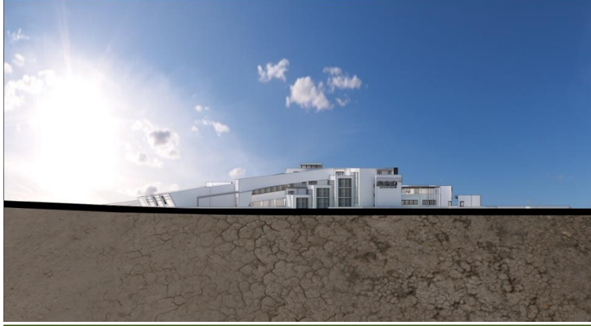
الشكل (2-13): الواجهة الغربية.
