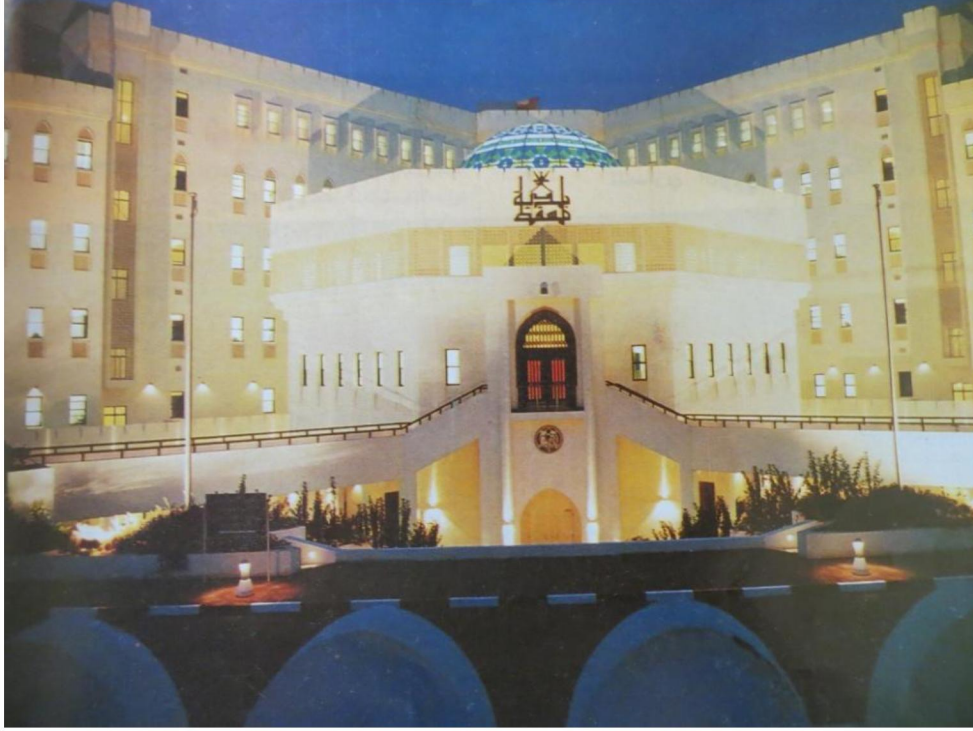
شكل 6 - 12 الواجهة الخلفية من المبنى
