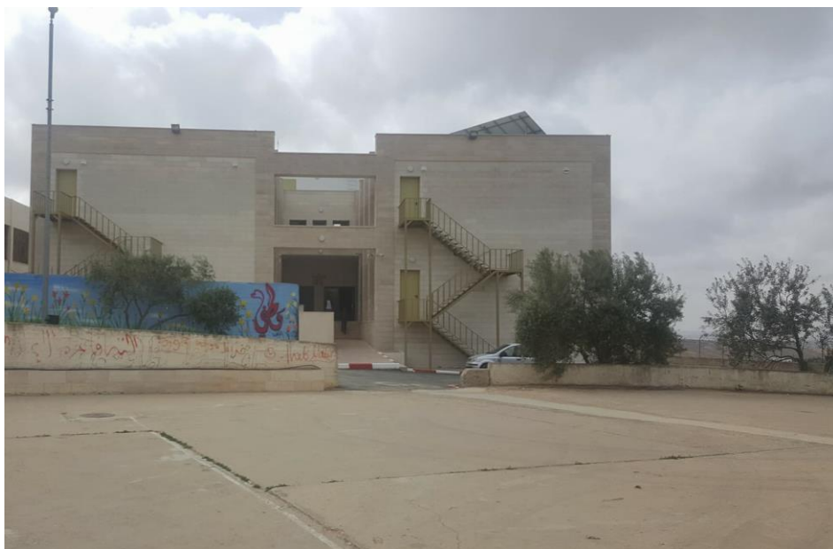
الشكل (4.13) : الواجهة الجنوبية الغربية المصدر: فريق العمل .
