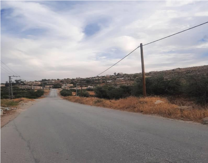
شكل (3-5) صورة توضح عدم وجود انارة على الطريق
