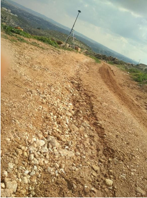
الشكل ( 3-4 ) يوضح وجود حفر بالطريق وبالتالي تجمع المياه وسوء تصريفها في فصل الشتاء .
