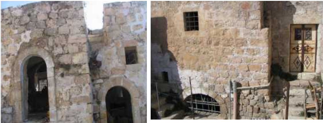
الشكل - : واجهة خارجي وواجهة داخلية في المبنى
