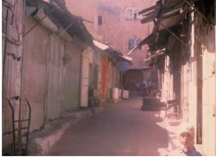
الشكل ( - ) : ضعف البنية التحتية وقلة عمليات الترميم
