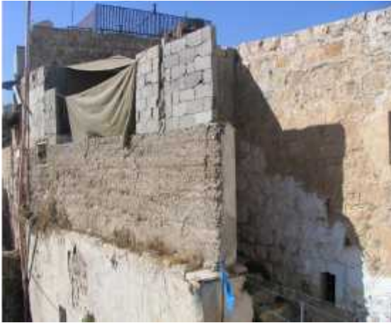
الشكل - : الجدار الخرساني المضاف
