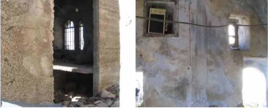
الشكل - : الجدران الداخلية مقصورة بقصارة جيرية أو قصارة إسمنتية.
