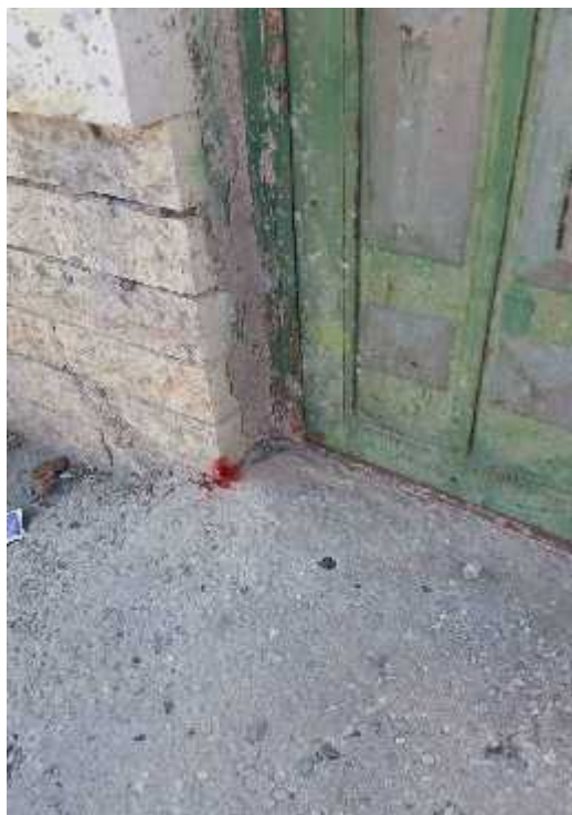
□ □ □ □ (□ - □) :- توضح زاوية البناء المجاور لبيت آل الشرباتي.
