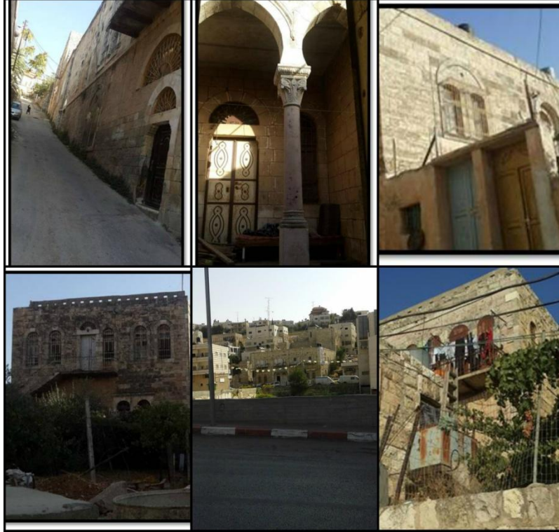
الشكل (4-7): مباني مركز ابن رشد-المصدر: الباحثون، 2015
