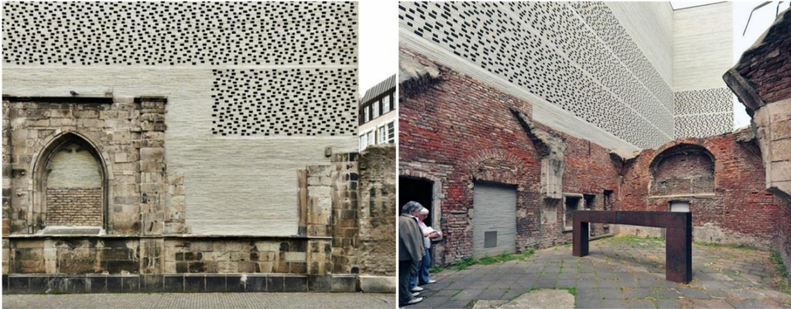
الشكل (6-40): صور تظهر الربط بين القديم والجديد والفتحات التي أعطت خفة للمبنى-
