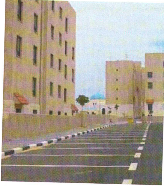
الشكل ( ١٠ ) يبين أحد مواقف المركبات الموزعة على محيط المجاورة ، المصدر : بلدية بيت لاهيا - قسم التخطيط
