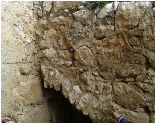
الشكل ( 5-42 ): صورة توضح تعدد المواد المستخدمة في الجدران .
