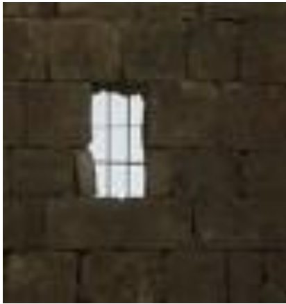
الشكل ( 5-38 ) :صورة توضح النافذة في الجدار الشمالي في مبنى البرج .
