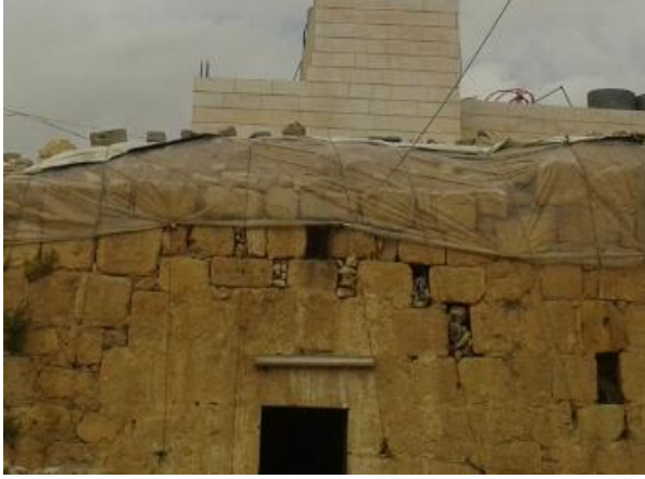
الشكل ( 5-12 ) :صورة توضح تغطية السطح بالبلاستيك .
