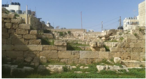
الشكل ( 5-28) : بقايا المنصة والأدراج في مبنى البرج القديم .
