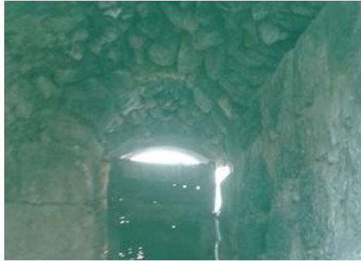
الشكل ( 5-18) : الاسقف من حجارة الدبش الغير منتظمة في السقف
