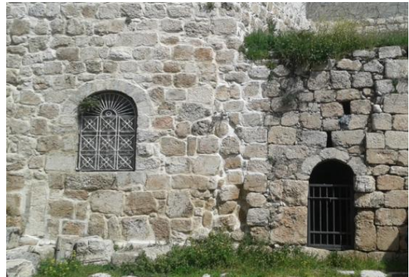
الشكل ( 5-32) : جزء من الجدار الشرقي لمبنى البرج القديم .
