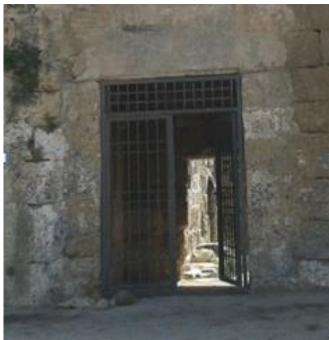
الشكل ( 5-40 ) :صورة باب المدخل الحالي لمبنى البرج في الجدار الشمالي .
