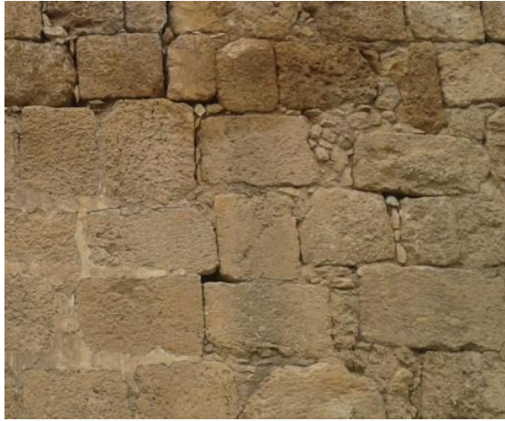
الشكل ( 5-13 ) :صورة توضح تشققات الحلول .
