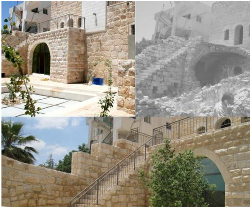
الشكل ( 2-20 ) :صورة توضح المبنى الذي تم ترميمه من قبل البلدية
