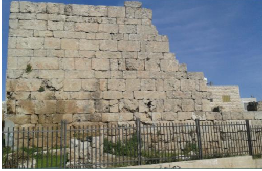
الشكل ( 5-29) : الجدار الغربي لمبنى البرج القديم
