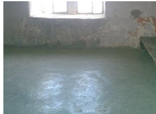
الشكل ( 5-19) : أرضية المونة الإسمنتية في تجمع العقيلي
