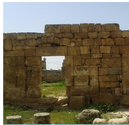
الشكل ( 5-43 ): المدخل الشرقي لقاعة البرج والحجارة غير المرتبة بالشكل الصحيح .
