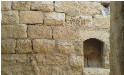
الشكل ( 5-16 ) : الحجارة المستخدمة في الواجهات الخارجية
