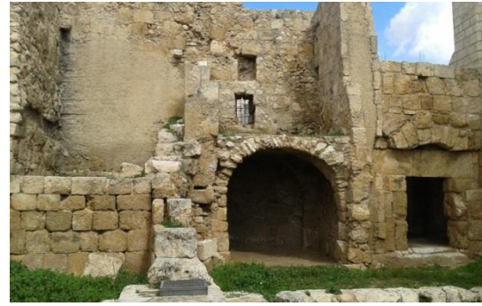
الشكل ( 5-30) : الجدار الشمالي لمبنى البرج القديم ذو المحاريب الثلاثة .
