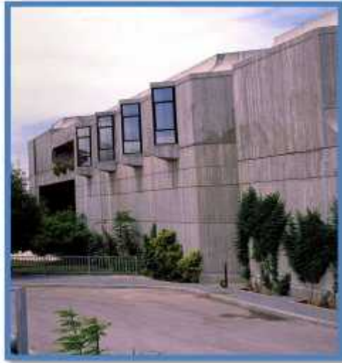
الصورة (٥:٥) الواجهة الشمالية الشرقية
