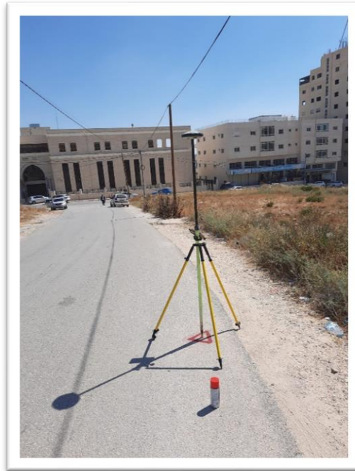
صورة رقم 4 صورة توضح الأعمال الميدانية في الشارع
