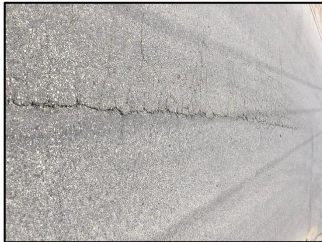
الشكل (4-9) صورة توضح بعض التشققات في الطريق.
