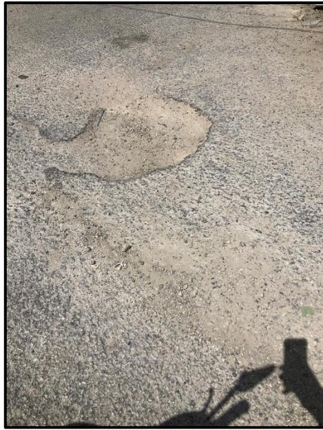
الشكل (4-5) صورة لبعض الحفر التي تتجمع مياه الأمطار فيها
