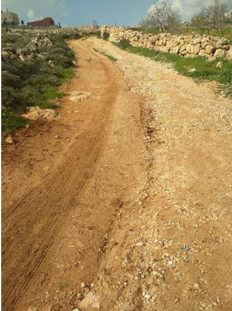
الشكل ( 6-3 ) : يوضح عدم وجود اشارات ارشادية
