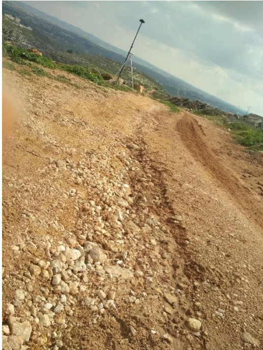
الشكل ( 4-3 ) يوضح وجود حفر بالطريق وبالتالي تجمع المياه وسوء تصريفها في فصل الشتاء .
