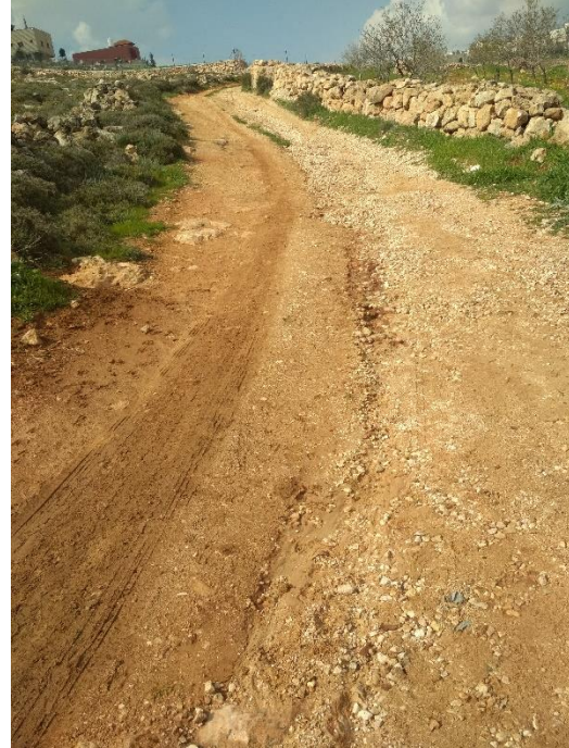
الشكل ( 4-3 ) يوضح وجود حفر بالطريق وبالتالي تجمع المياه وسوء تصريفها في فصل الشتاء .
