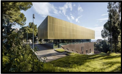
الشكل (13-3) الواجهة الجنوبية في النهار
