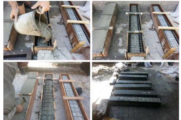
Fig. 7 Pouring SCC concrete
