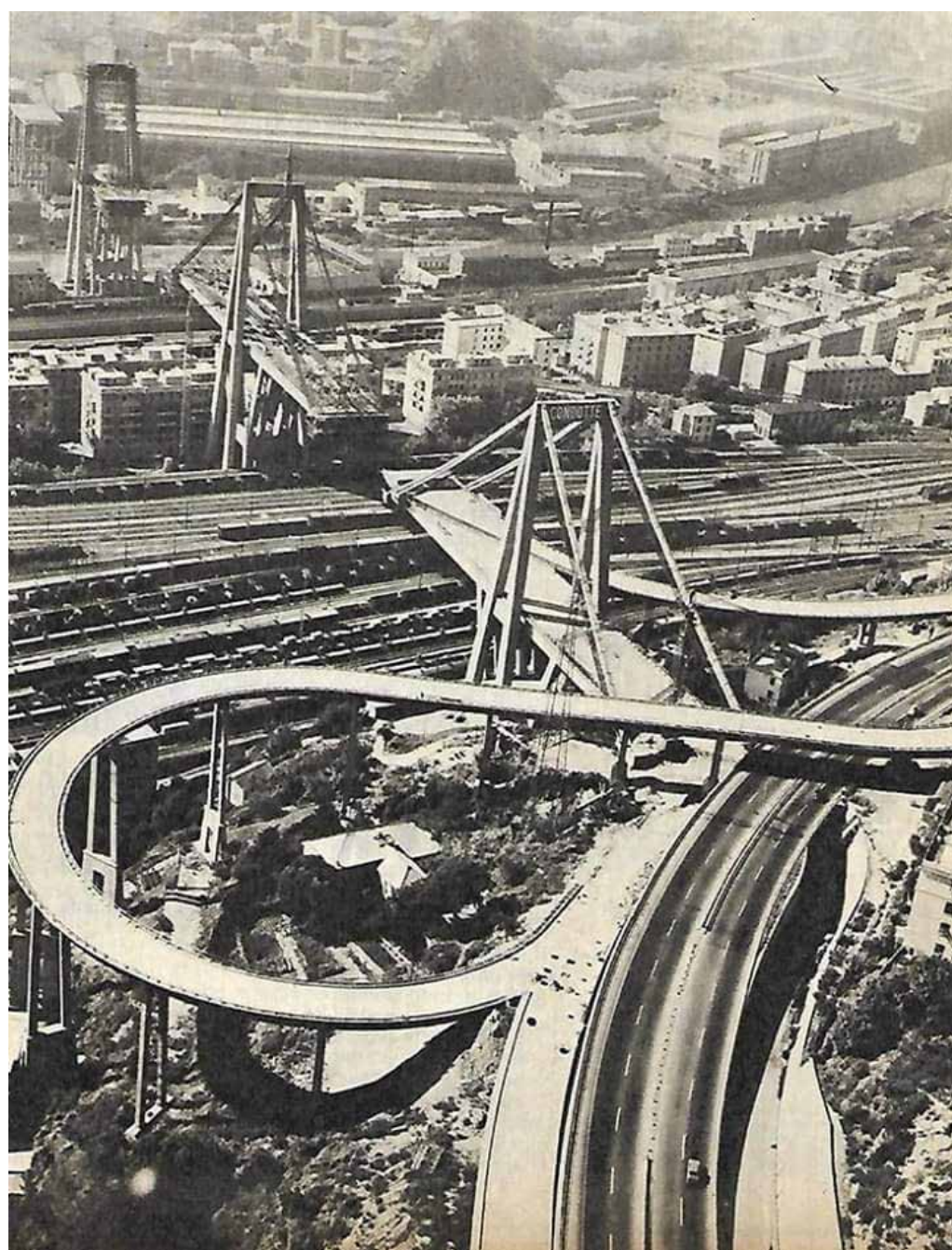
Figure 1 – The viaduct on the Polcevera creek under construction. Genova, 1966. ( https://it.wikipedia.org/wiki/File:Costruzione_Viadotto_Polcevera_1966.jpg )
