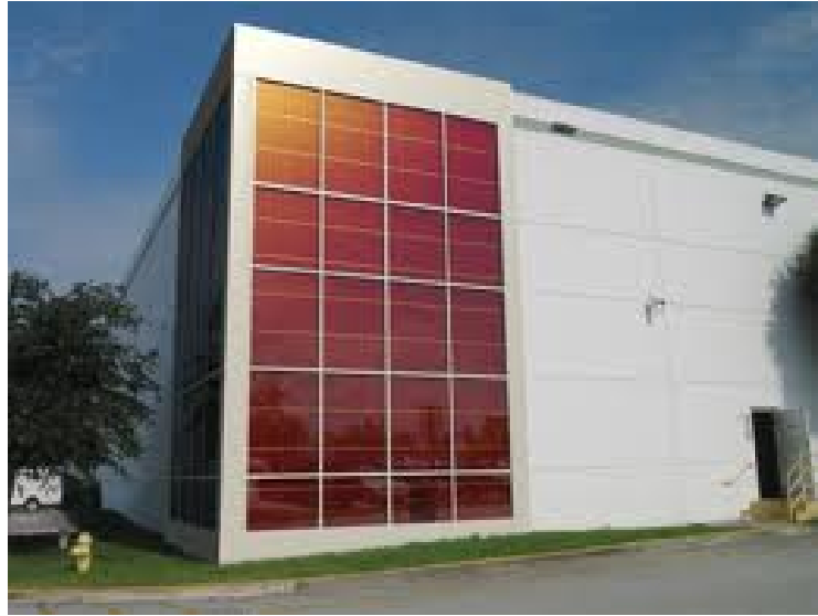
الشكل (5-25): صورة توضح ألواح زجاجية حديثة عاكسة ليلا وشبه شفافة ليلا (المصدر: www.greatbuildings.com )
