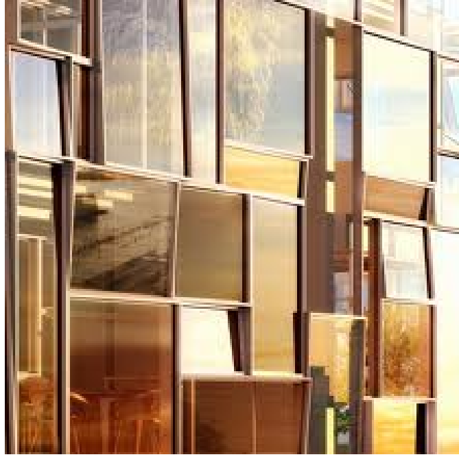
الشكل (5-24): صورة توضح ألواح زجاجية حديثة عاكسة ليلا وشبه شفافة نهارا (المصدر: www.greatbuildings.com )
