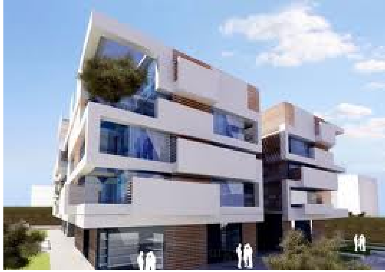
الشكل (5-26): صورة لواجهة مبنى استخدمت فيه ال Curtin walls لتحقيق الخصوصية
