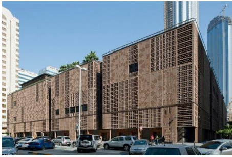
الشكل (3-46): لقطة خارجية للسوق المركزي
