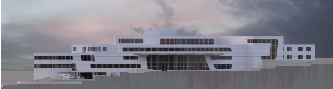
الشكل (8-2): الواجهة الجنوبية.
