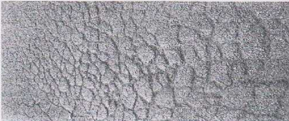
الشكل رقم (٢-٣) الشقوق التماسحية.
