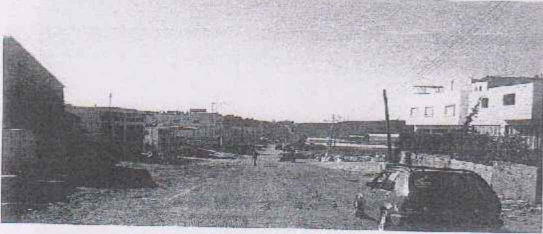
الشكل (٣-٢٤) إضاءة الطريق.
