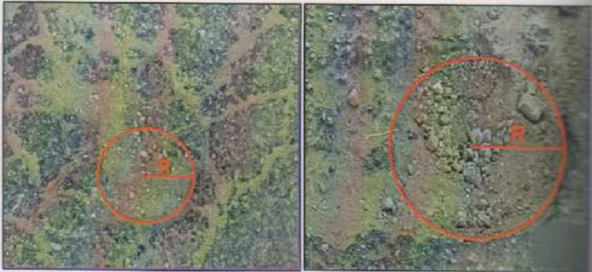
الشكل (٣-٣) حفر ذات قطر وعمق مختلف عند المحطة رقم (0+500).
