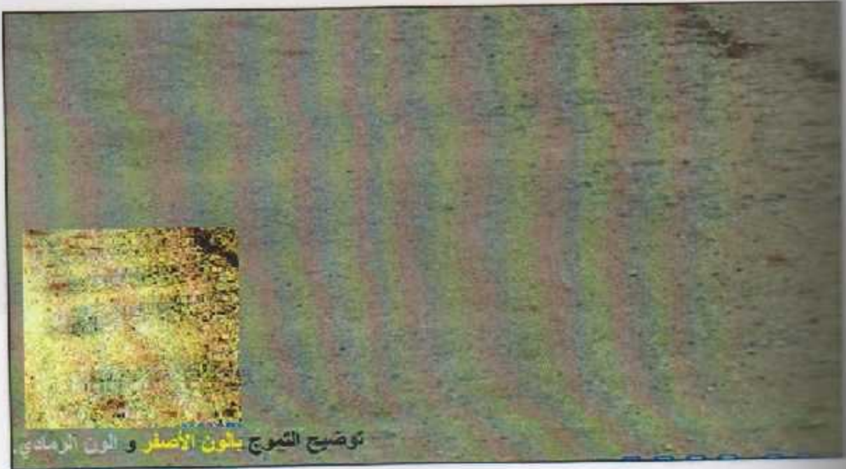
الشكل (٦-٣) تموجات متتالية ومتقاربة عند المحطة رقم (0+100).
