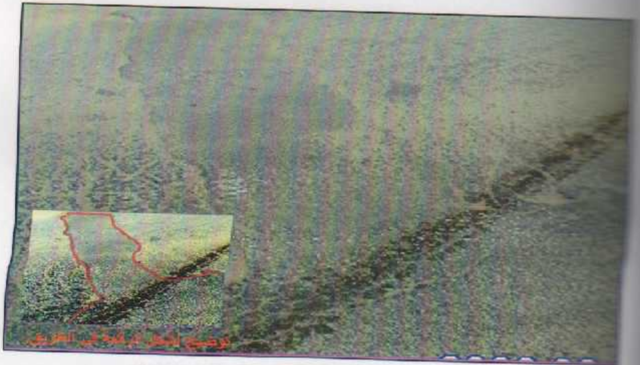
الشكل (٧-٣) مشكلة الترقيع في شارع الدعوة عند المحطة رقم (0+500).
