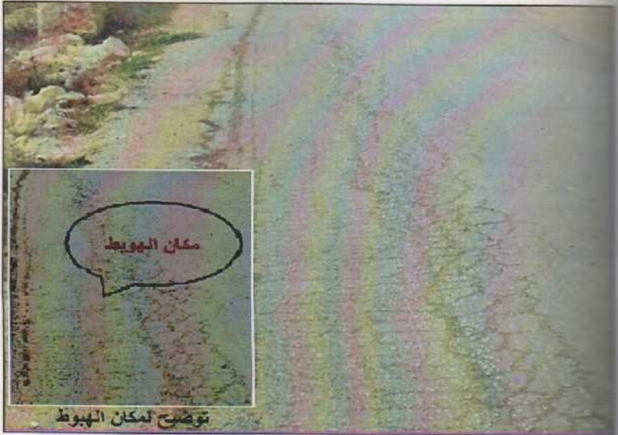
الشكل (٨-٣) مشكلة الهبوط في شارع الدعوة عند المحطة رقم (0+350).
