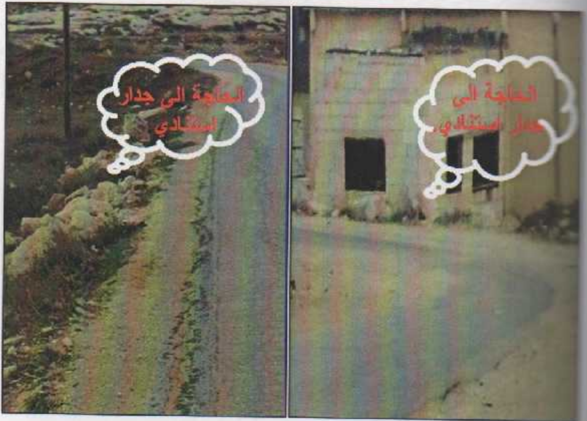
الشكل (٩-٣) الحاجة لوجود جدران استنادية عند المحطة رقم (0+350) و المحطة رقم (0+100).
