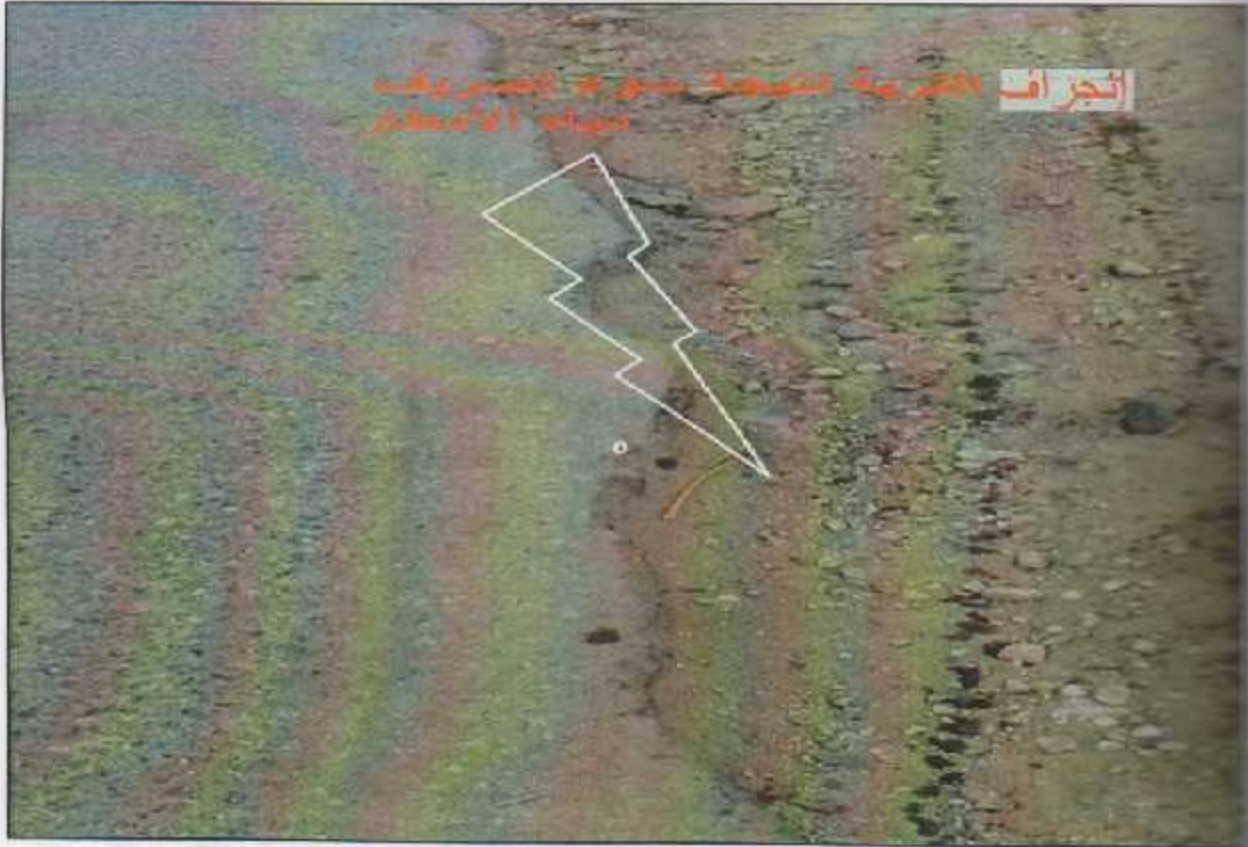
الشكل (١٧-٣) تأثير مياه الأمطار على جوانب الطريق عند المحطة رقم (0+350).
