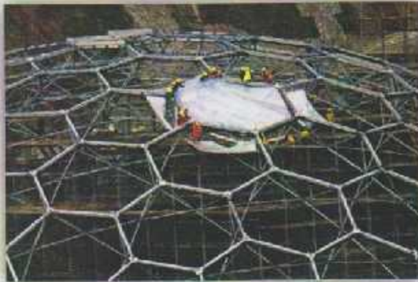
شكل ( 20.4 ) : صورة توضح طريقة إنشاء القبة الإحيائية،المصدر: http://4.bp.blogspot.com/_VyTCyizqrHs/SkjkmLNVmEI/AAAAAAAAAEMc/Wct2BtTd1CE/s400/installinga_panel.jpg
