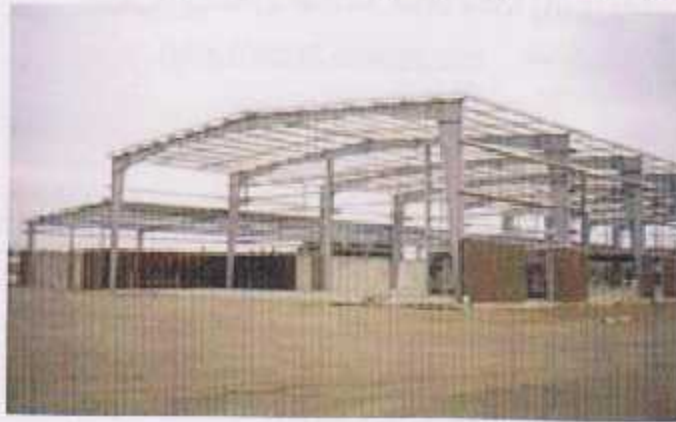
صورة (3-9) الإنشاء بالإطار المتماسك من الصلب الرياضية.
