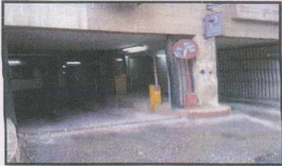
الشكل (24_4) المدخل الرئيسي لمواقف السيارات
