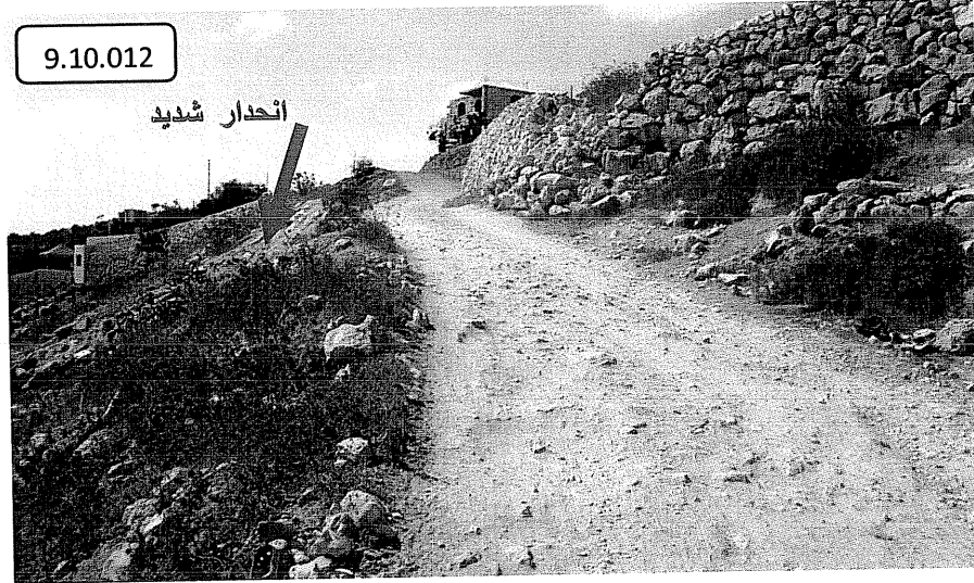
الشكل ( 4-8 ) يوضح جزء من الشارع يتطلب إنشاء جدار استنادي
