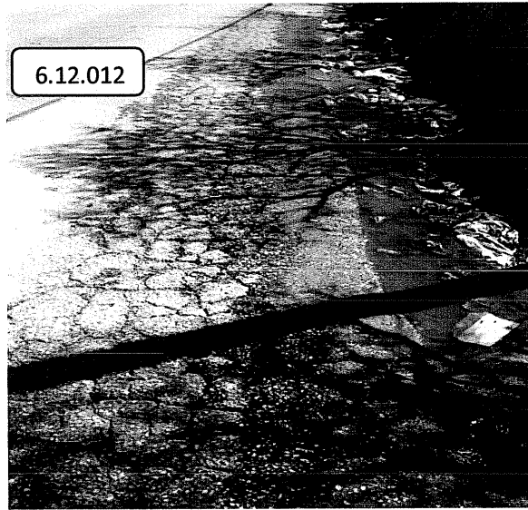
الشكل (1-3) مشكلة تصريف المياه
