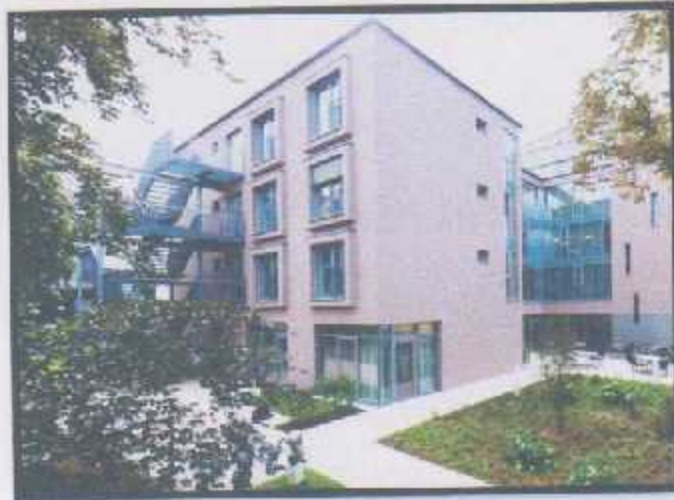
الشكل (١٦.٤) درج الهروب في مبنى المصدر: ( http://www.archdaily.com/145383/ , visited in 2/11/2013)
