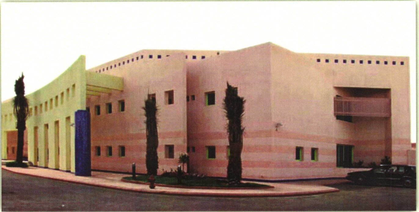
الشكل(4-10): الواجهة الرئيسية للسفارة
