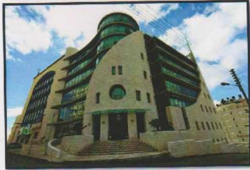
شكل (2.3): مدخل شركة الهاتف الخليوي (جوال) المبنى الجديد المصدر: بشارلي قيس-مكتب عمارة
