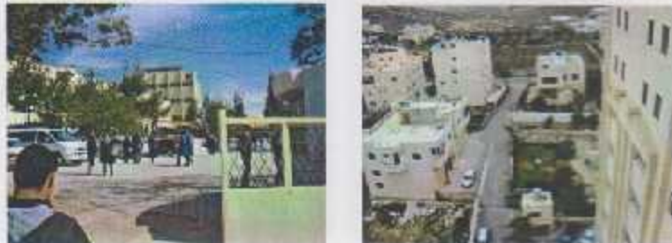
شكل(٦-١٤): صور توضح عدم وجود مدخل مناسب يليق بالجامعة (١)
