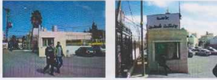
شكل(٦-١٥): صور توضح عدم وجود مدخل مناسب يليق بالجامعة (٢)
