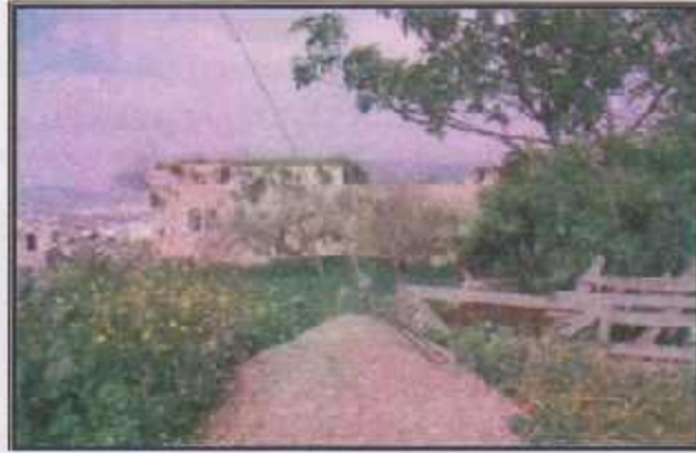
صورة منطقة الدخول المقترحة لمبنى دار الشيخ قبل إجراء التعديلات عليها وتحويلها إلى منزل المصدر: الباحثة صور (٥٠٣)
