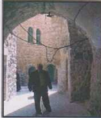
تبين الصور أسلاك الكهرباء المتنتلية صور (٢-١٨) تصوير فريق العمل (٢/٥/٢٠١٠)
