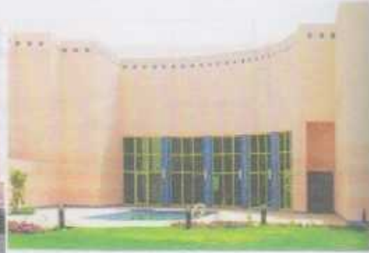
الصورة (ج-4-13) جزء من الواجهة الشرقية للمسفارة
