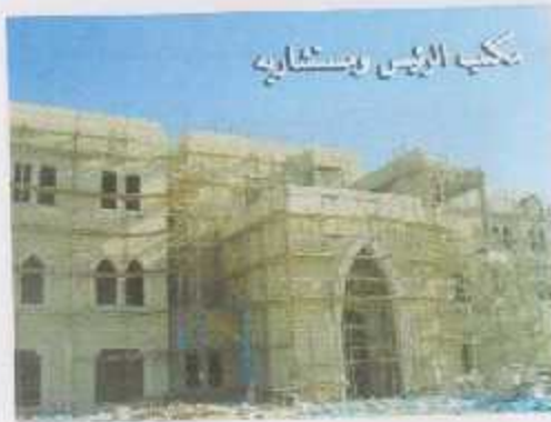
الصورة (ب-1-6) مبنى مكتب الرئيس الذي يتم إنشاؤه في المقاطعة
