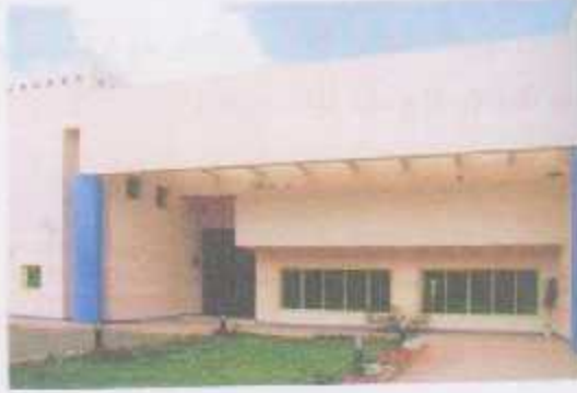
الصورة (ب-4-13) جزء من الواجهة الغربية للمسفارة
