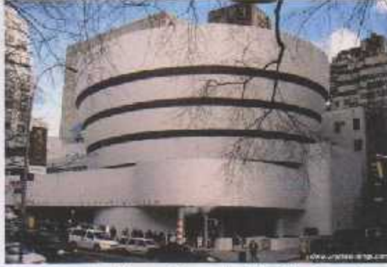
الصورة (3-51): تأثير اللونين الأبيض والأسود في الواجهة المصدر: www.greatbuilding.com
