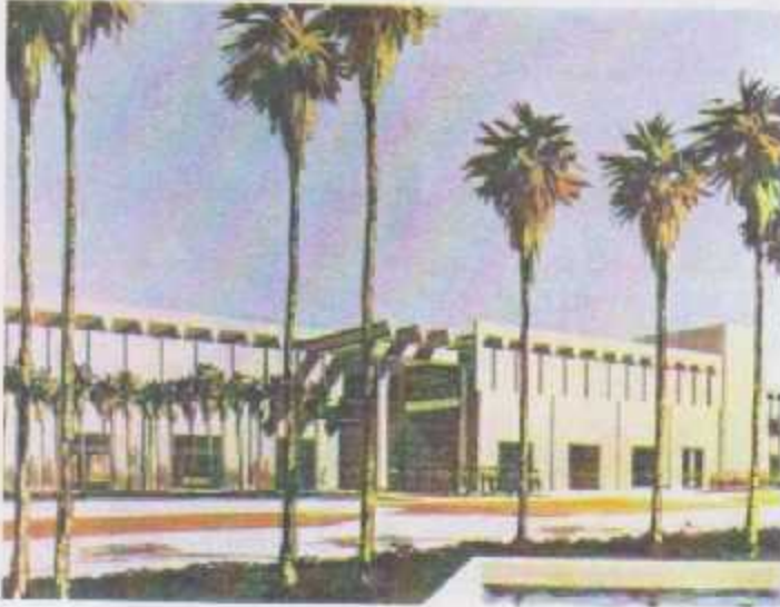
الشكل (4-5) : مبنى سكن الطلاب ويقع في الجانب الشمالي للمنطقة التعليمية. المصدر: (مجلة البناء 107، ص 18، 1999)
