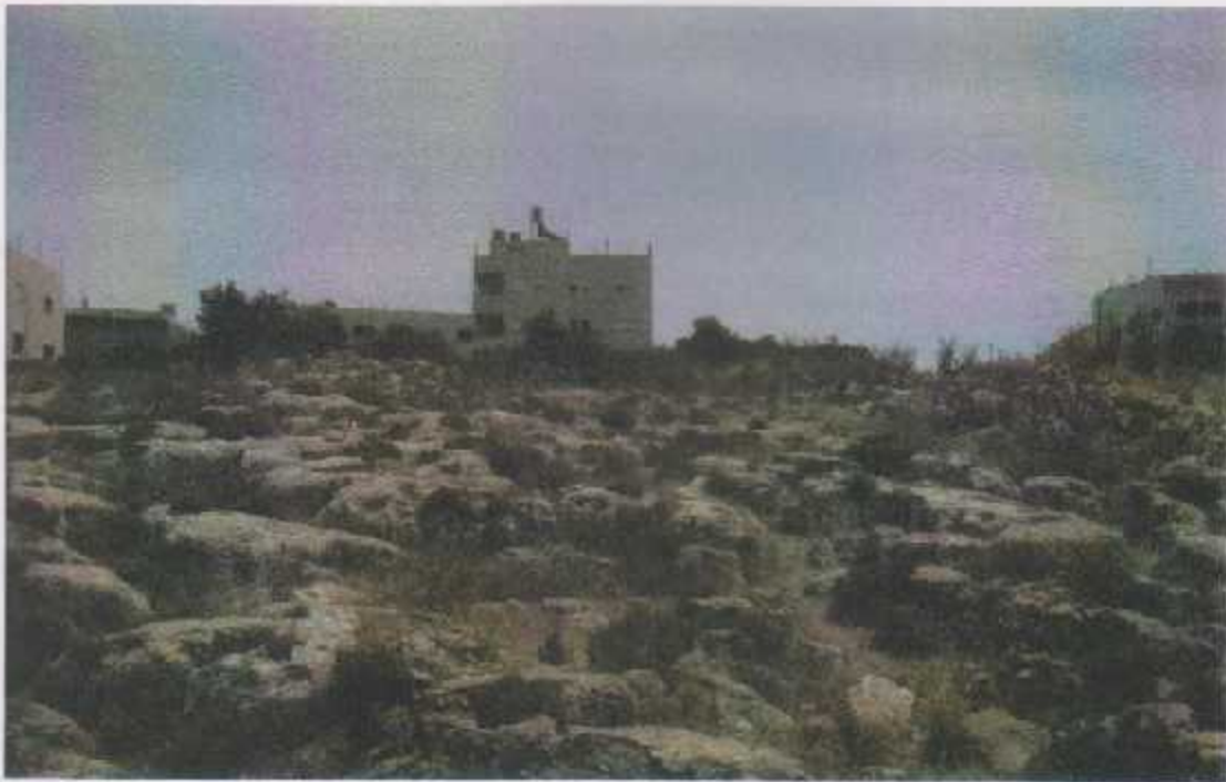
صورة (5-10) الواجهة الشرقية ، فريق البحث. 2010/5/1
