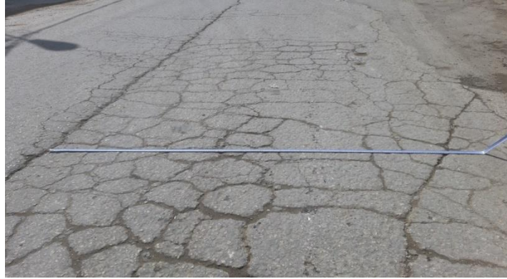
الشكل ( 3-6 ) : يوضح وجود تشقق التماسح في الطريق وعرضه 2م
